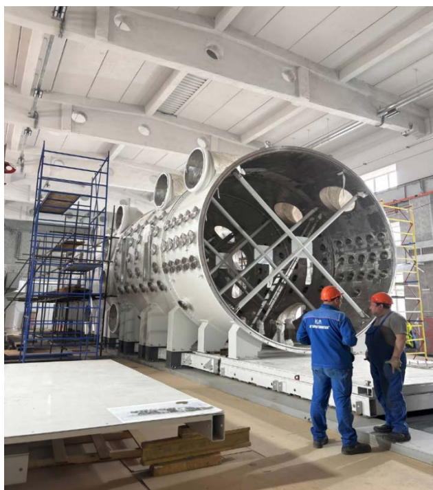
Рисунок 1 – Стенд ПЕРСТ в процессе монтажа секций 2025 г.
